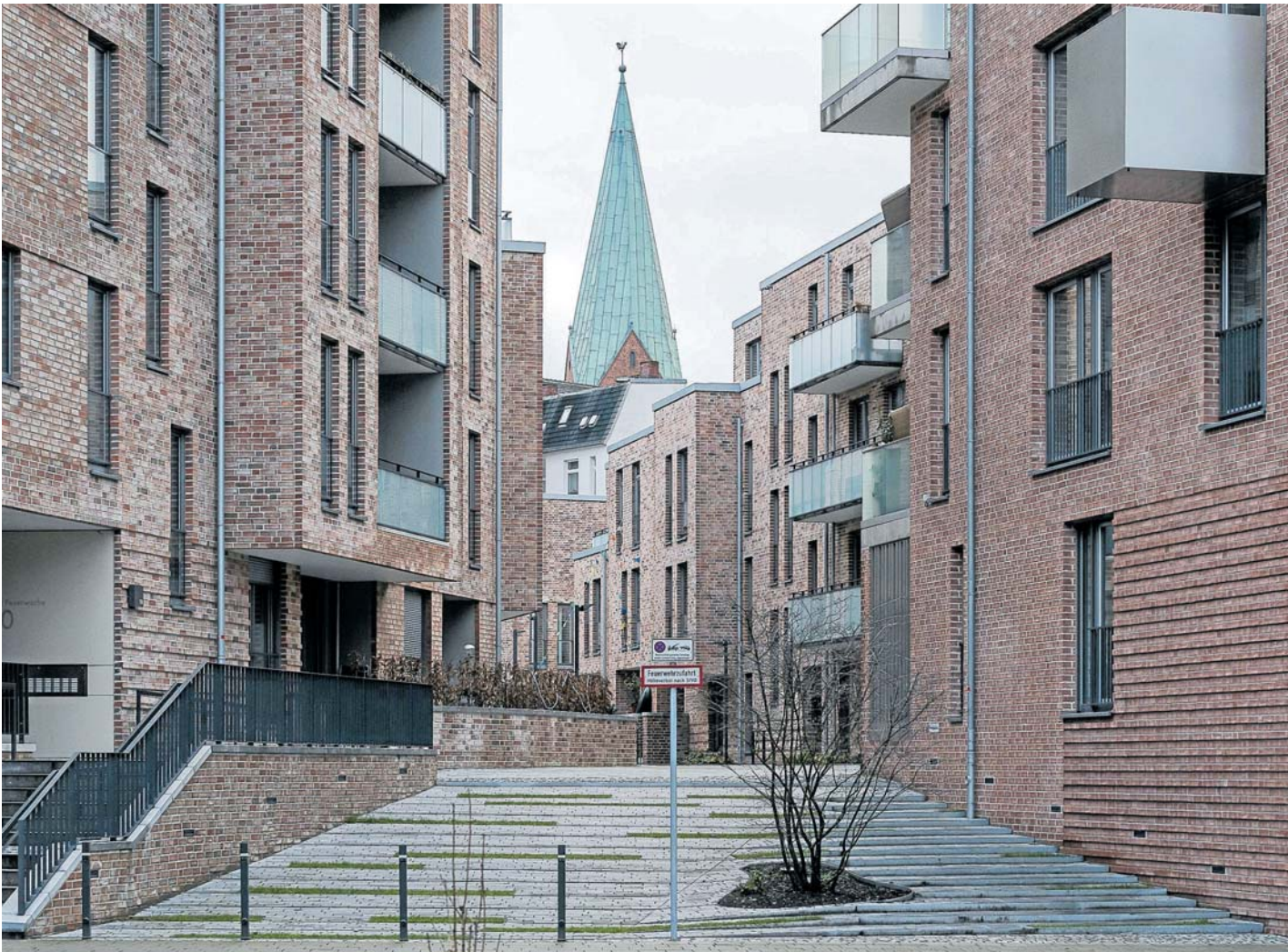
Manchem gefällt's: Die Fachzeitschrift Polix zeichnete das Projekt Alte Feuerwache in Kiel sogar aus. Die Jury sprach von einer „behut-samen Aufwertung der Innenstadt, bei der die städtebauliche Typologie nicht aus den Augen verloren wurde“.
